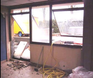
Ouverture d'une trémie
