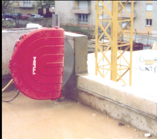
Modification sur chantier de neuf
