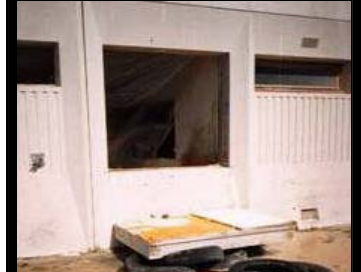
Découpe nette d'une maçonnerie
