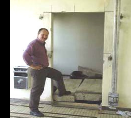
Ouverture de porte dans un mur en béton armé
