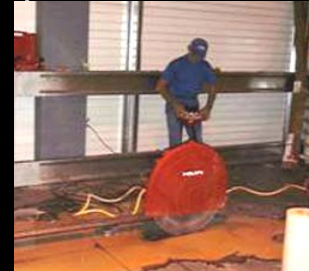
Rainurage du sol pour passer une évacuation
