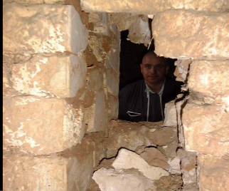
Réalisation d'ouverture dans un mur ancien
