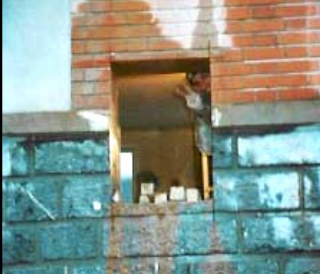
Découpe de maçonnerie et de pierre
