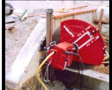
Rupture nette entre zone à démolir et construction
