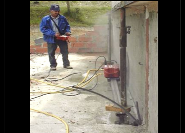
Rupture nette entre zone à démolir et construction
