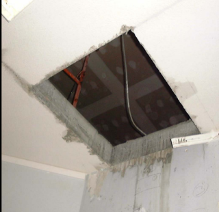
Réalisation de baies
